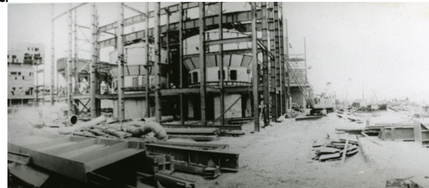
Будівництво об'єктів цеху хімічної підготовки води (1984)
